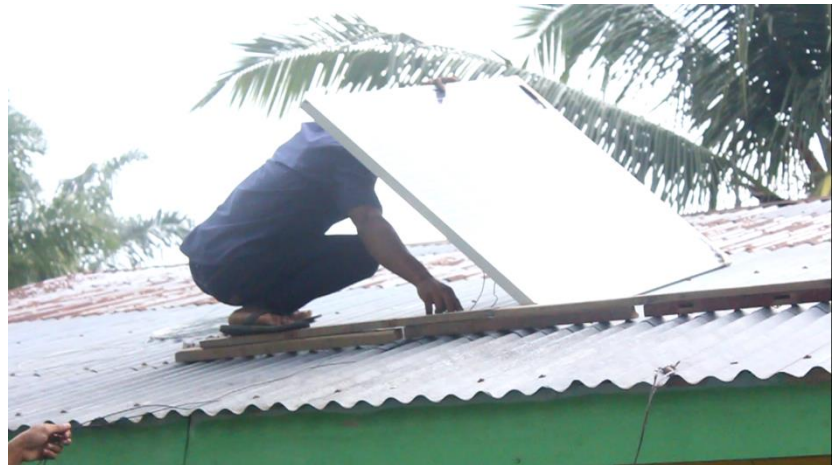
Pemasangan Solar Panel di Pesantren Darussa'adah (YSL)
